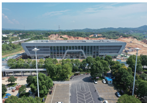
武广高铁衡山西综合客运枢纽
