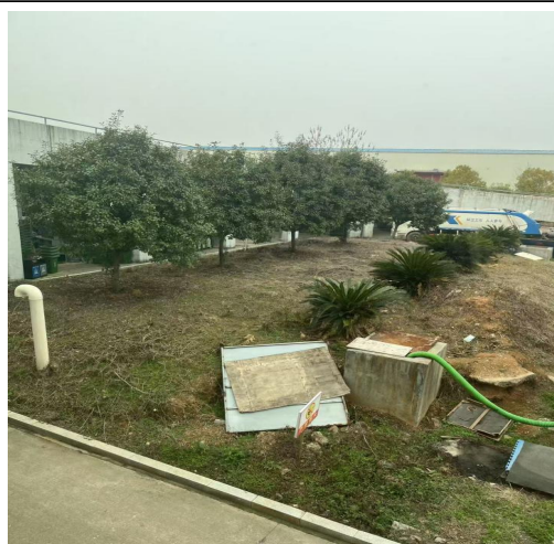
渗滤液收集池
